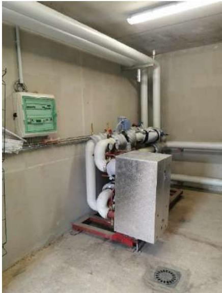
Echangeur CHAUFFAGE P= **430 kW**
