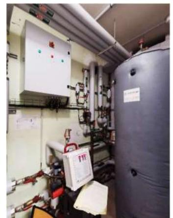
L'objectif sera de remplacer la résistance d'appoint trop faible par une résistance nettement plus importante de manière à réduire sensiblement le temps de chauffe actuel (18 heures avec 3 kW) et d'arrêter par conséquent la sous-station dès la fin de la saison de chauffe (mai / juin).
