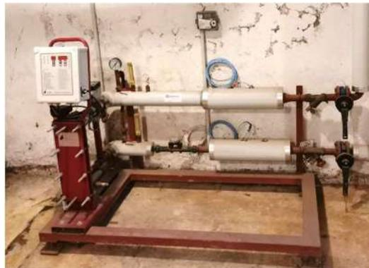
Echangeur PRODUCTION ECS P= 55 kW
