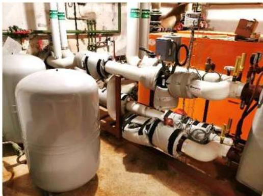
Echangeur CHAUFFAGE P= 435 kW
