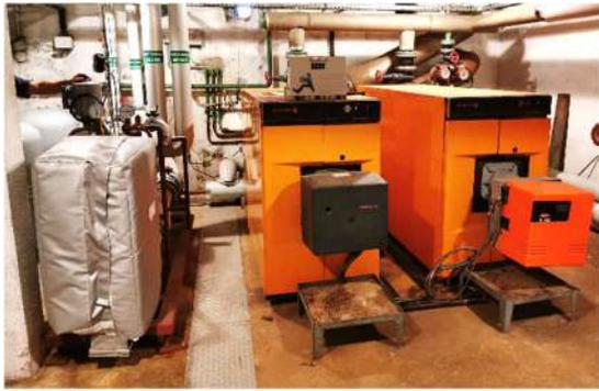
Deux chaudières FIOUL non déposées et mises A l'arrêt
