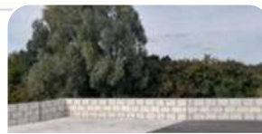
Création d'une plateforme gravats et déchets verts sur déchèterie du Grand-Lucé (ouverture le 1 er octobre 2025)
