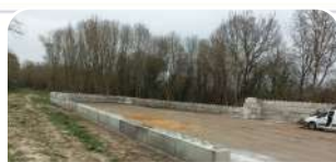
Réfection de la plateforme déchets verts sur la déchèterie de La Ferté-Bernard (mars 2025)
