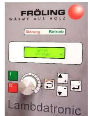
Armoire de protection et pilotage de la chaudière biomasse : automate FRÖLING type H 3000
