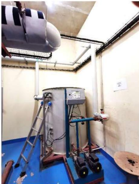
Station d'expansion et de maintien de pression avec bache ouverte d'une capacité **1 800 litres**
