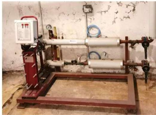
Echangeur PRODUCTION ECS P= 55 kW
