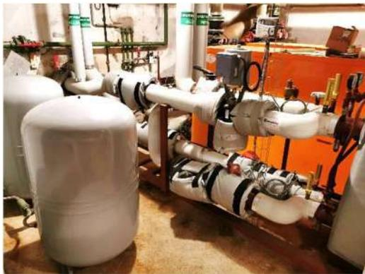
Echangeur CHAUFFAGE P= 435 kW
