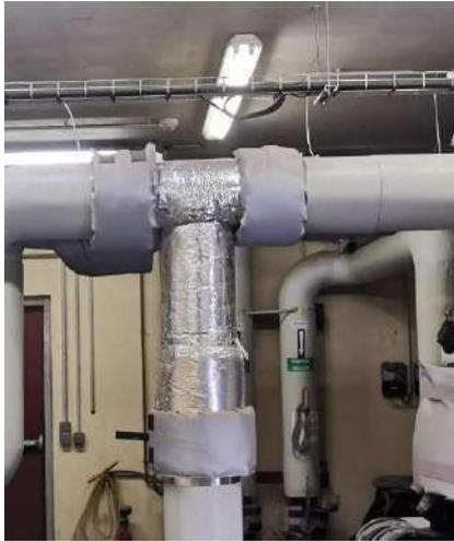
Vanne 3 voies « HORS SERVICE » prévue déposée.
