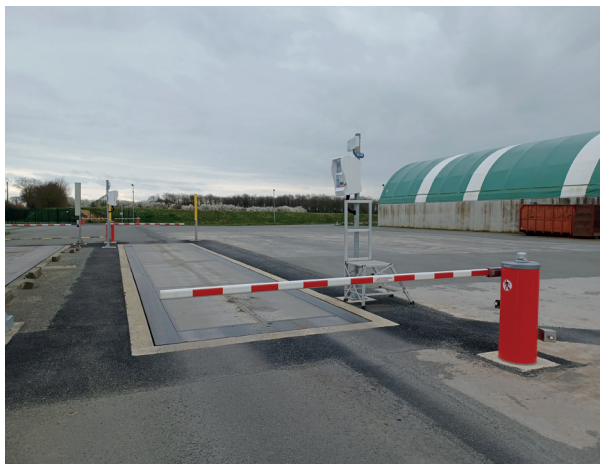
Depuis le 3 octobre 2022, PAPREC - COVERED exploite le site dans son intégralité.
